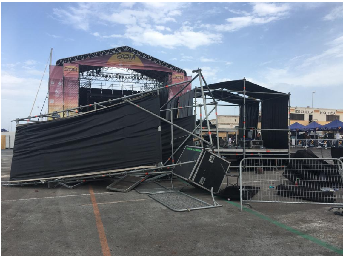
Efectos del fuerte viento causados en el recinto del concierto de LEIVA el sábado 13 de agosto del 2022, momentos antes de la hora prevista de apertura de puertas.
